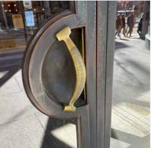
Rekonstruktion och gjutning av äldre handtag. (NK i Stockholm)
